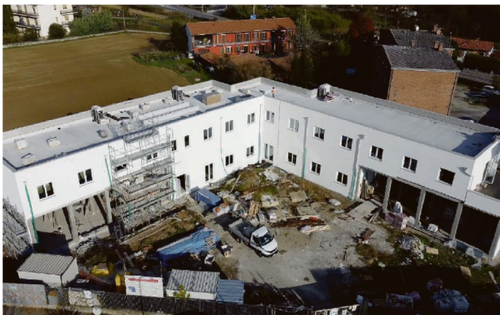
Il cantiere del futuro Polo Emergenziale
