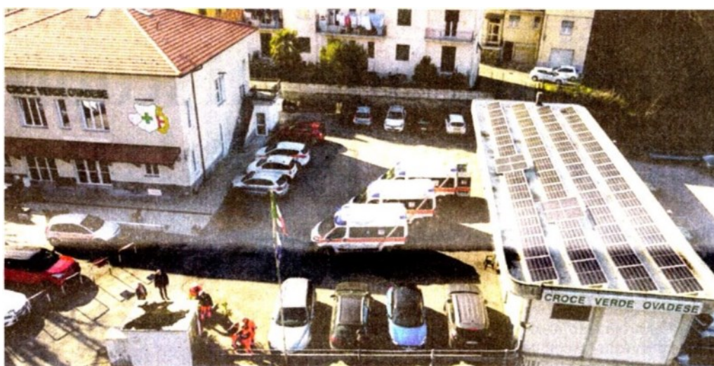
VISTA AEREA Il tetto completamente rinnovato e l'impianto fotovoltaico installato sui garage
