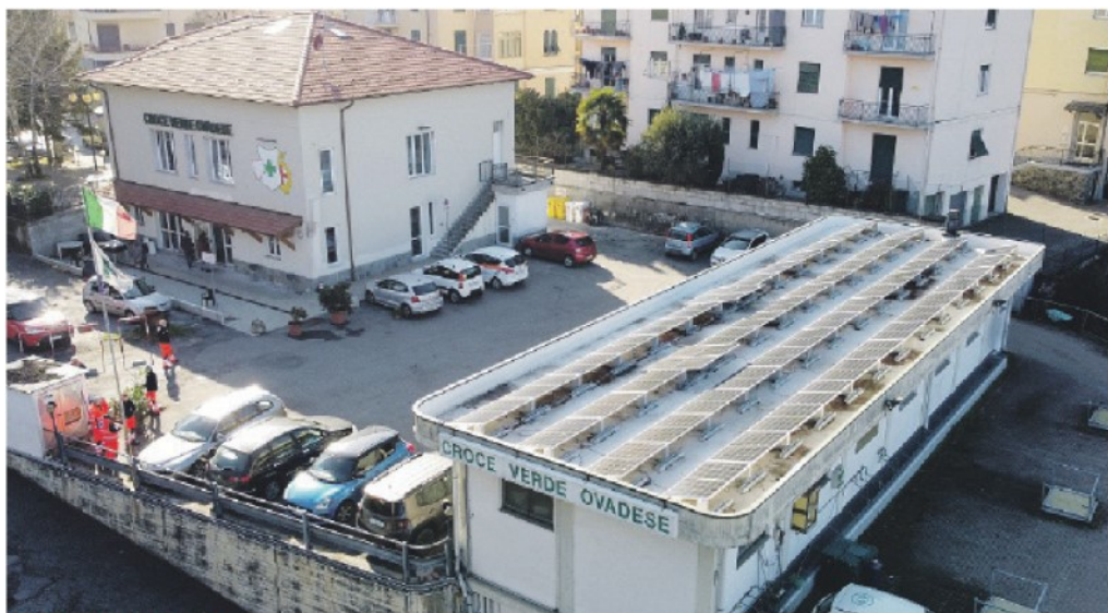
IMMAGINE AEREA Sullo sfondo la sede, in primo piano i garage con il nuovo impianto
