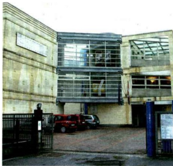
IN FOTO, la struttura di via 25 aprile che ospita la Sala Antonetto
