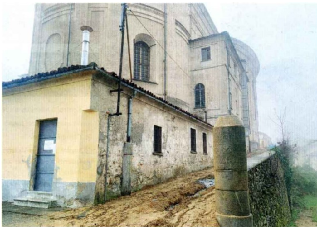
I lavori di consolidamento a valle della chiesa parrocchiale di Santa Maria della Motta.
