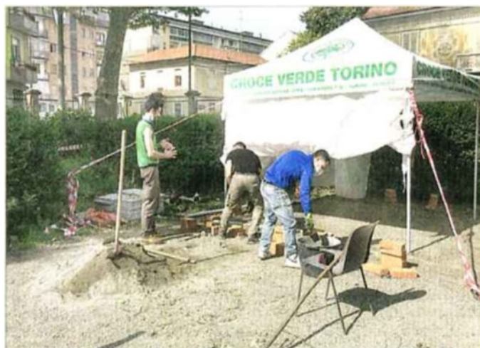
I volontari all'opera nella realizzazione della pavimentazione sotto il gazebo del sodalizio
