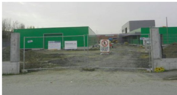
IL CANTIERE IN STRADA CANELLI IN VIA DI COMPLETAMENTO
