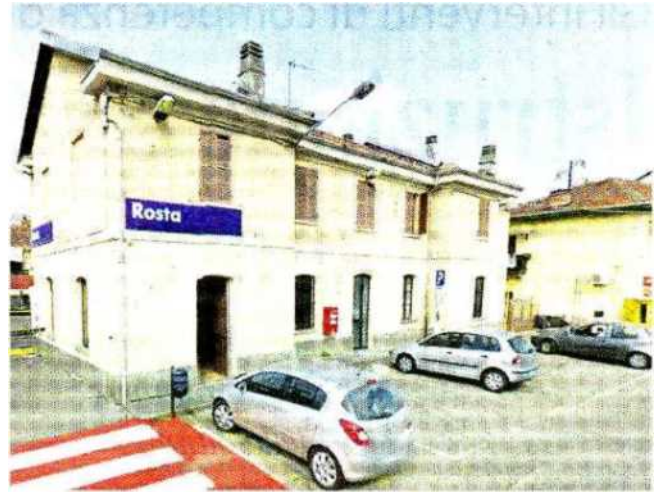
La stazione ferroviaria di Rosta
